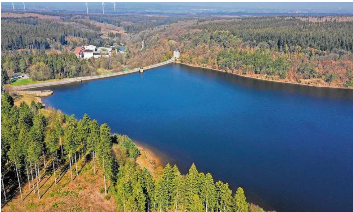
Die Dreilägerbachtalsperre ist ein zentraler Bestandteil der Trinkwasserversorgung in der Region Aachen.
