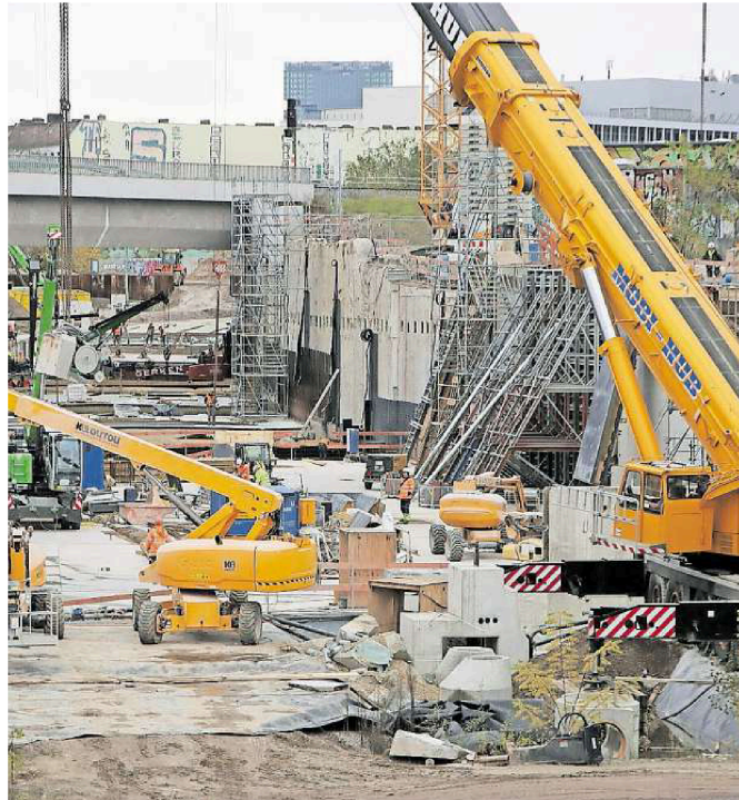
Ingenieure und Ingenieurinnen arbeiten zum Beispiel auf Baustellen. FOTO: DPA
