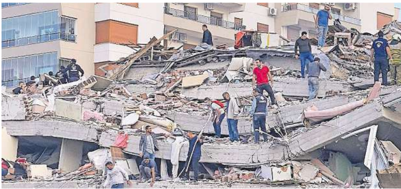
In Izmir versuchen Rettungskräfte und Anwohner Menschen zu befreien, die unter den Trümmern eines eingestürzten Gebäudes begraben sind. FOTO: DPA
